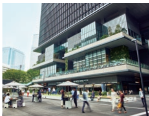
TOKYO TORCH Terrace (東京駅側より)
