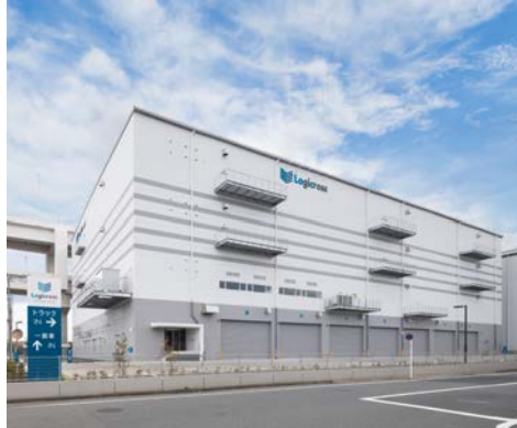
ロジクロス横浜港北
