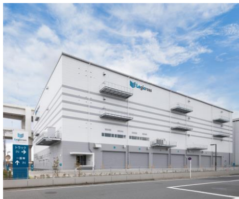
ロジクロス横浜港北
