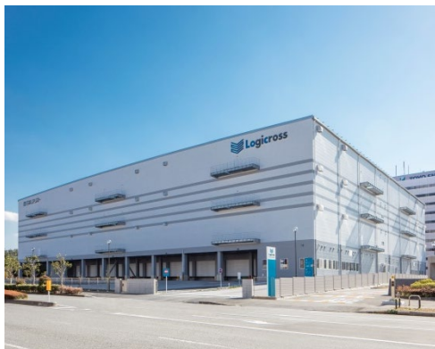
ロジクロス習志野
