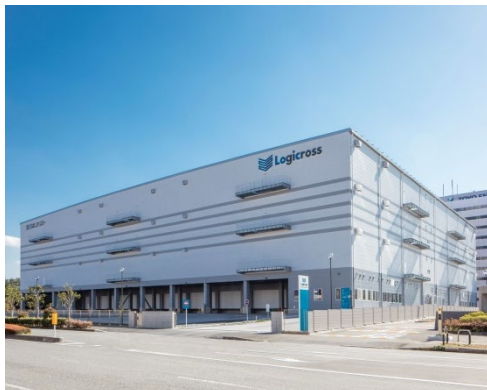
ロジクロス習志野
