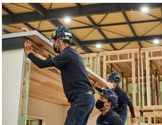
▲工場内での建設作業
