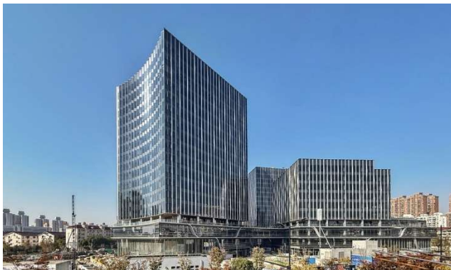
▲ Crystal Bridge（竣工写真）
