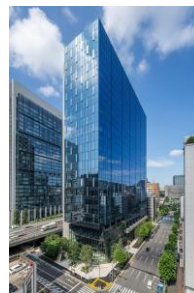
▲大手町ゲートビルディング外観
