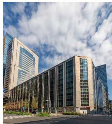
▲新大手町ビル
