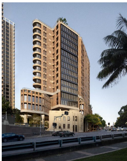
▲外観およびヘリテージ保存部分（低層の白壁建物部分）
