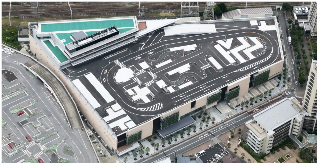
▲ I 期施設屋上（北東より）
