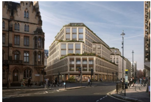
▲ 「1 Victoria Street」完成イメージ
