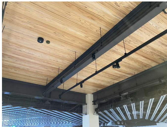
▲公園施設天井デッキ
