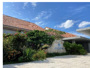
▲下地島空港ターミナルビル
