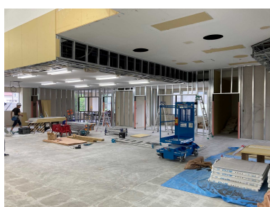
<リニューアル工事中>
