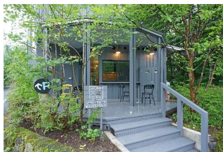
▲1F ウッドデッキ
