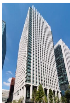
2012 年 大手町フィナンシャル シティ ノースタワー、 サウスタワー
