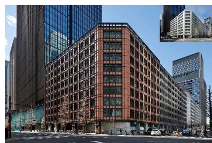
▲リノベーション後の大手町ビル
