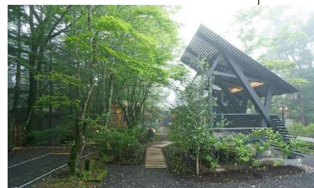
▲「WORK×ation Site 軽井沢」
