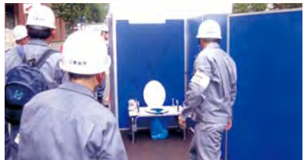
路上でのマンホール直結型トイレ組み立て訓練
