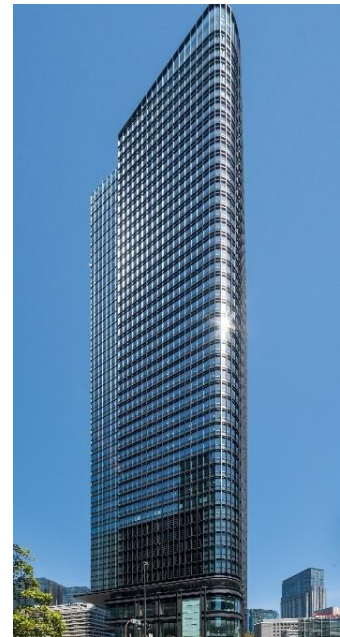
常盤橋タワー
