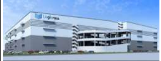
▲三菱地所：（仮称）ロジクロス座間（2023年6月頃竣工予定）
