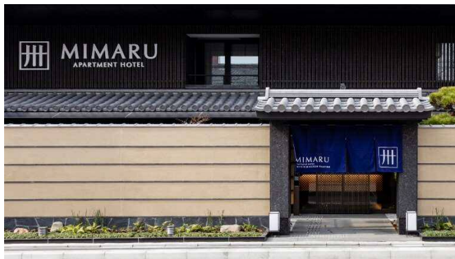
▲「MIMARU 京都 西洞院高辻」外観
