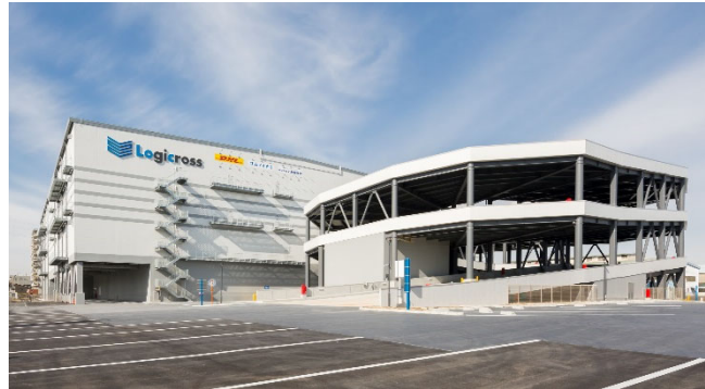
▲「ロジクロス名古屋笠寺」外観
