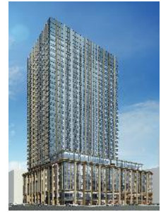
丸の内二重橋ビル 外観
