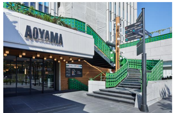
リニューアル後の1階エントランス
