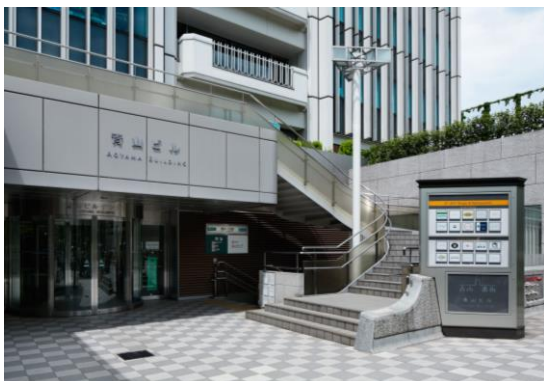
リニューアル前の1階エントランス
