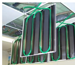
天井・壁面の輻射パネル
