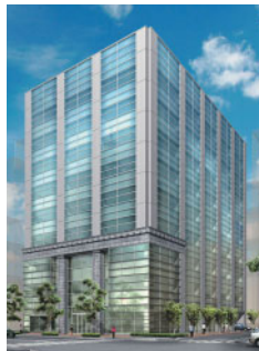
(仮称) 仙台中央三丁目ビル
