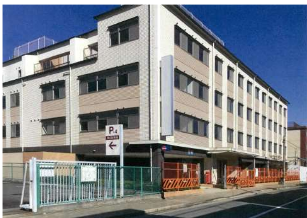
▲リノベーション後の外観（一部塗装予定）
