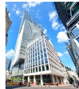
8 Bishopsgate (2023年6月竣工)
