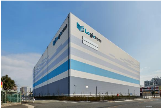
ロジクロス大阪大正 2026年1月竣工
