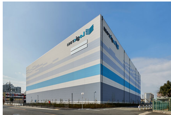
Logikross Osaka Taisho Completion : Jan. 2026
