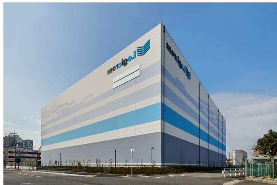
ロジクロス大阪大正 2026年1月竣工
