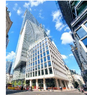
8 Bishopsgate (2023年6月竣工)
