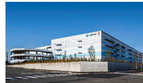
ロジクロス相模原 2023年12月竣工
