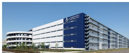
ロジポート川崎ベイ ・ 2021年3月期売却
