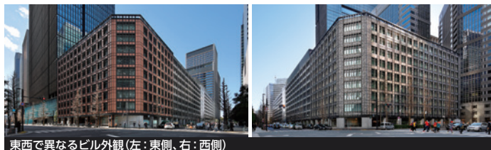
東西で異なるビル外観(左:東側、右:西側)
