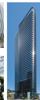
▲常盤橋タワー
