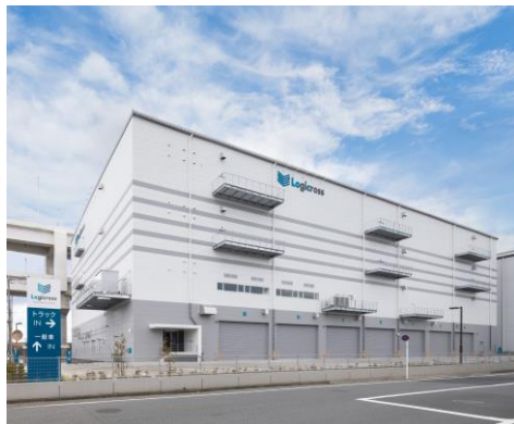
ロジクロス横浜港北
