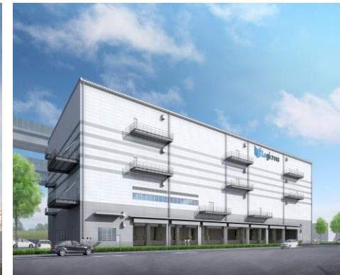
ロジクロス横浜港北
