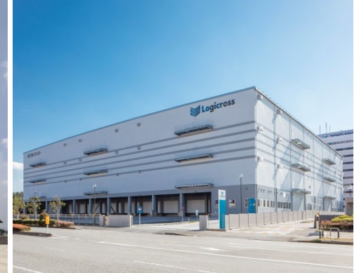
ロジクロス習志野
