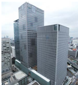
大手町一丁目地区第一種市街地再開発事業 (手前が経団連会館、中央がJAビル)
