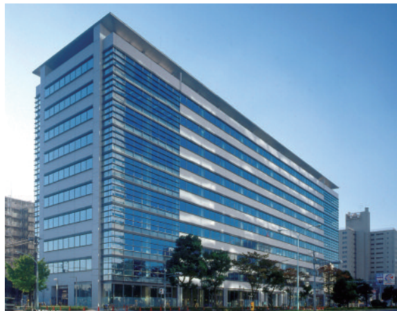
晴海センタービル
