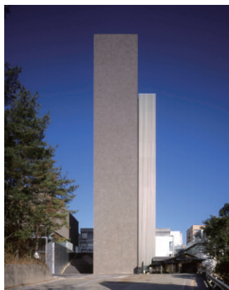
追手門学院大学中央棟 6号館
