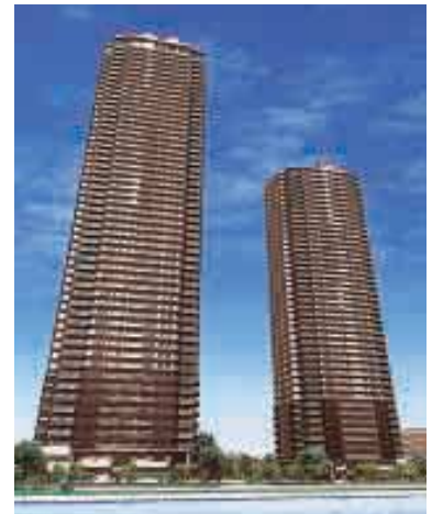
W Comfort Towers 総戸数1,149戸 平成17年4月竣工予定 共同事業者 三菱商事(株)、菱進都市開発(株)
