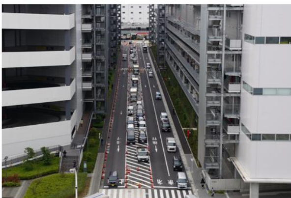
【A 棟・B 棟の間の車路】
