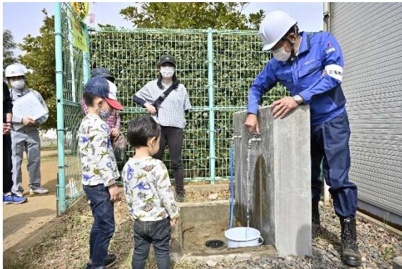
▲防災井戸から給水している様子
