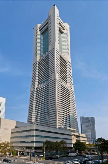
オフィスビル 国内主要都市でオフィスビルの開発、賃貸、運営管理業務を展開
