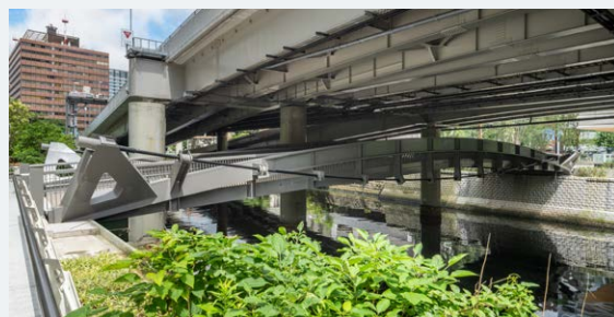
新たに架橋した「仲通り散歩橋」
