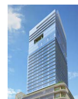
神戸三宮雲井通5丁目地区再開発事業 延床面積：98,600m 2 竣工予定：2027年度
