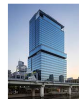
大阪堂島浜タワー 延床面積：67,000m 2 竣工：2024年4月
