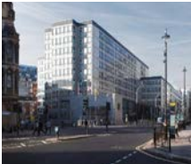
「1 Victoria Street」 既存建物
