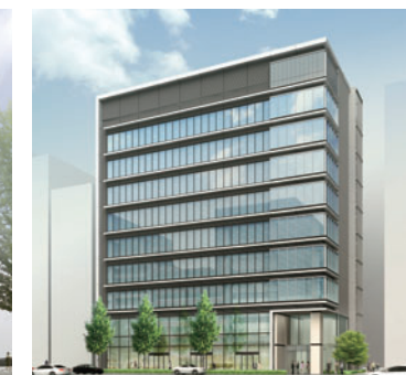
田町フロントビル
