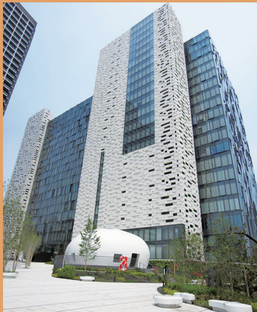
新宿イーストサイドスクエア 都営地下鉄大江戸線・東京メトロ副都心線「東新宿」駅に直結する約3.7haの大規模開発プロジェクト「新宿イーストサイド」内に位置する、1万人以上が就業可能なオフィスビル。基準階有効面積約1,800坪という都心最大級のフロアプレートと、約1.3haにも及ぶ緑豊かな外構空間を有します。2012年4月竣工。
