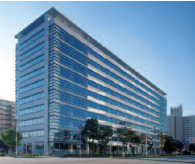
「晴海センタービル」 開発資金をノンリコースローンと共同事業者とのエクイティ出資により調達する、開発型証券化手法によるプロジェクト。再開発や区画整理事業が進展し、新たなビジネスゾーンとして注目を集める晴海地区でのオフィス・店舗からなる複合ビル。2006年11月竣工。
