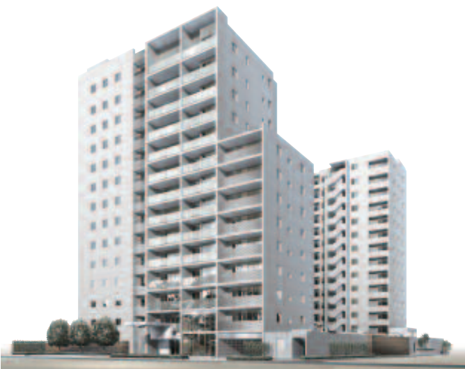
「本郷パークハウス ザ・プレミアフォート」 文京区本郷に、藤和不動産と共同で建設中の総戸数207戸の大規模マンション。免震構造を採用し安全に配慮すると同時に、居住空間に柱や梁を出さない、TWFS工法を採用。また、最新のセキュリティシステムを導入するなど、永住を深く意識している。
