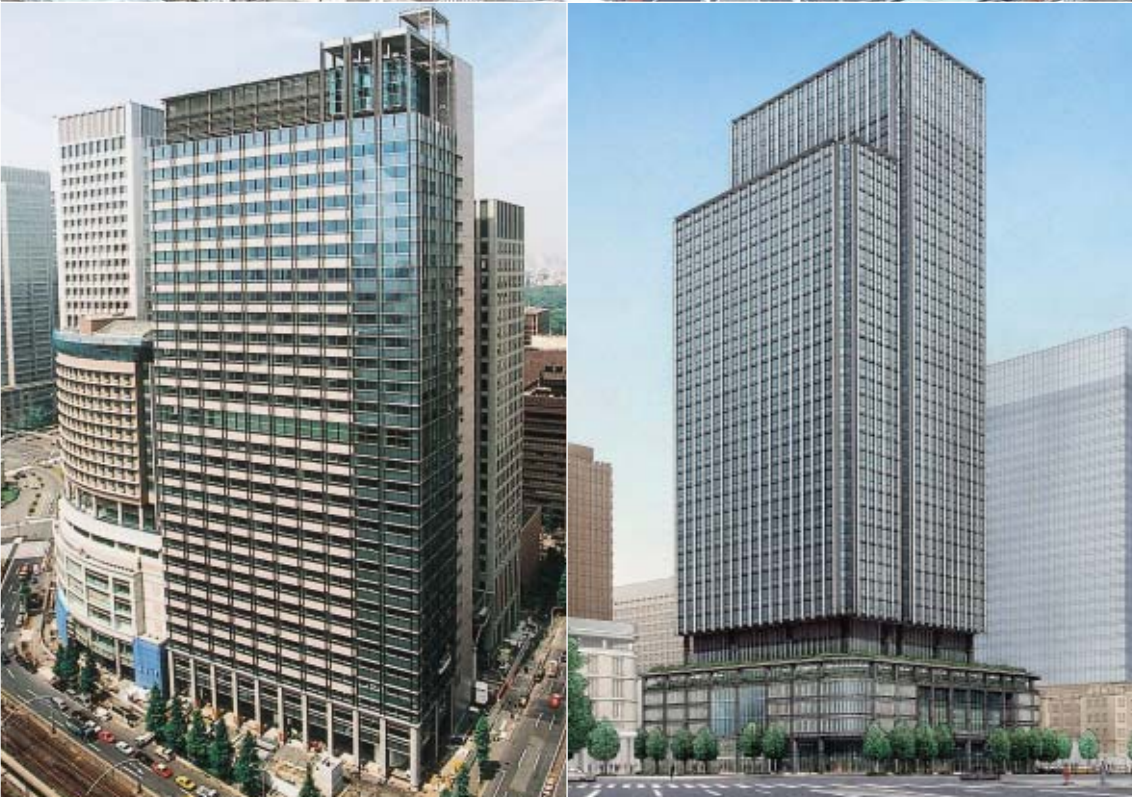
(右) 「新丸ノ内ビル」建て替え計画 2007年度の竣工を目指して計画が進行中です。新丸ノ内ビルが竣工する2007年、丸の内再構築の「第一ステージ」が完了します。
