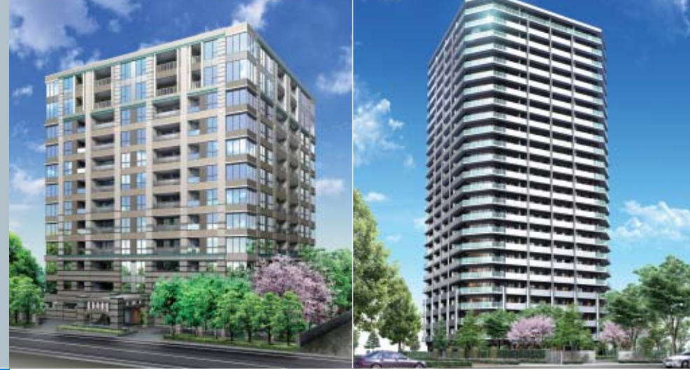
(左) 三番町パークテラス 桜苑 「三番町パークテラス 桜苑」は、三菱商事㈱と共同で千代田区三番町の高台に建設中の、地上12階建、総戸数102戸の高級マンションです。柱や梁を極力抑えた2,700mmの基準天井高や地下2層自走式駐車場など、クオリティーを追求した建物となっています。
