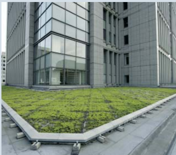
丸ビル低層部の屋上でヒートアイランド現象を和らげるために実施している屋上緑化
