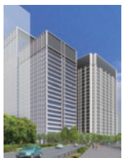
(仮称)大手町1-1計画 A棟: 2015年11月竣工予定 B棟: 2016年度竣工予定
